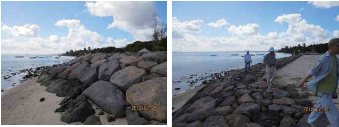
図 2.4.4 Pte. aux Sables の巨石護岸
