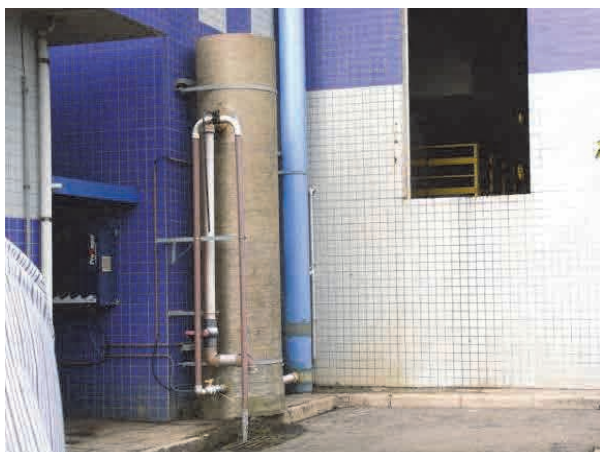
上水の高度処理（オゾン+活性炭処理）実験プラント。Irai ダムの藻類による異臭味対策を目的とする。プロジェクト終了後も実験は継続。
