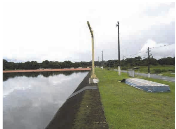
Guaratuba STP の仕上げ池。滞留時間は 20~35 日。処理効率改善のため、9 台のエアレータを設置する予定。
