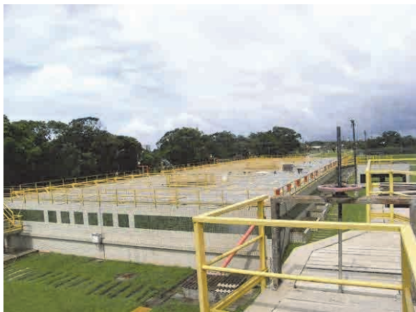
沿岸部の Guaratuba 下水処理場（STP）。処理水量約 5,000t/日。UASB 法+仕上げ池+塩素消毒。同市の 6 割の汚水を処理。臭気が課題。
