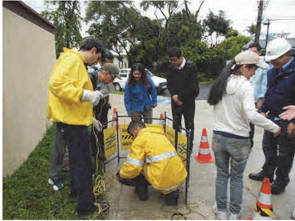
パイロットエリアでの下水管路診断の様子。マンホール周辺をカラーコーン、安全帯で区切り、適切な安全対策が実施されている。
