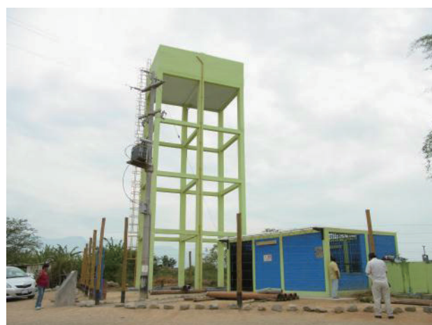
区役所及び水・衛生委員会により 運営・維持管理されている給水施設
