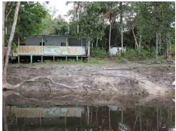
マナティの半自然下での飼育兼観察研究施設予定地。古い施設がある。
