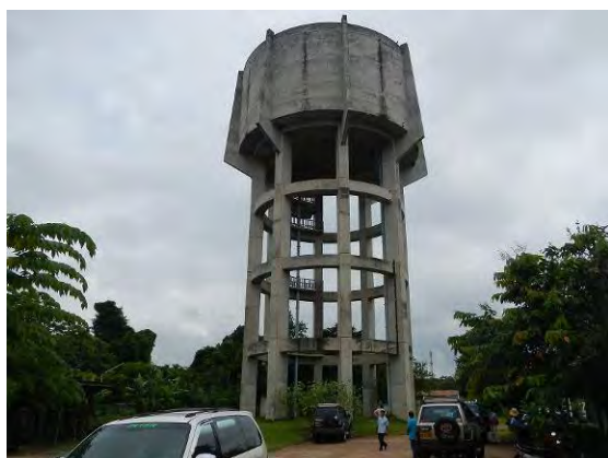
サラカム (Salakham) 高架水槽
