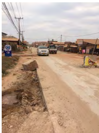
写真 6.5.3 舗装工事中道路
