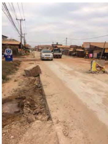
写真 6.5.3 舗装工事中道路
