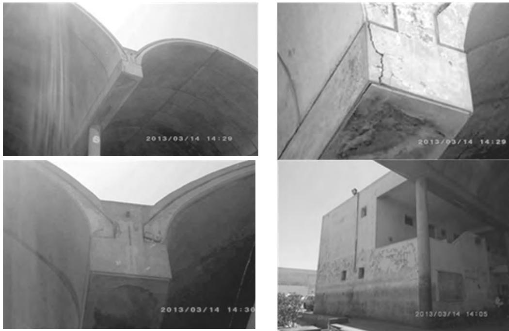
写真2-3 市場棟屋根、壁の劣化状況
