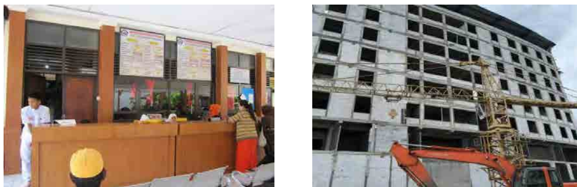
図 3-4 県立病院(左写真:既存病院受付、右写真:建設中の新病院)
