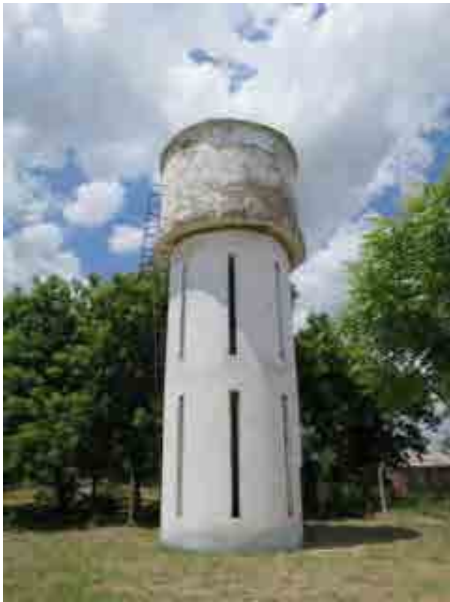
COWSO 管理の給水塔
