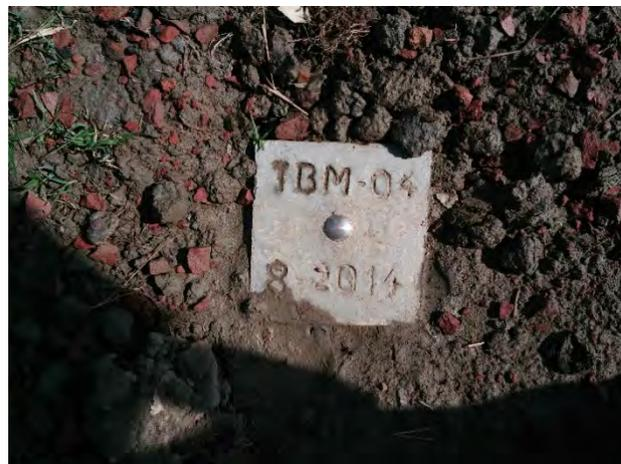
図 17.5-45 仮基準点の設置状況
