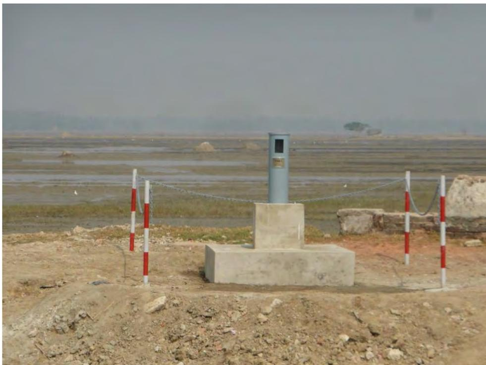
図 17.5-46 測量基準点の設置状況
