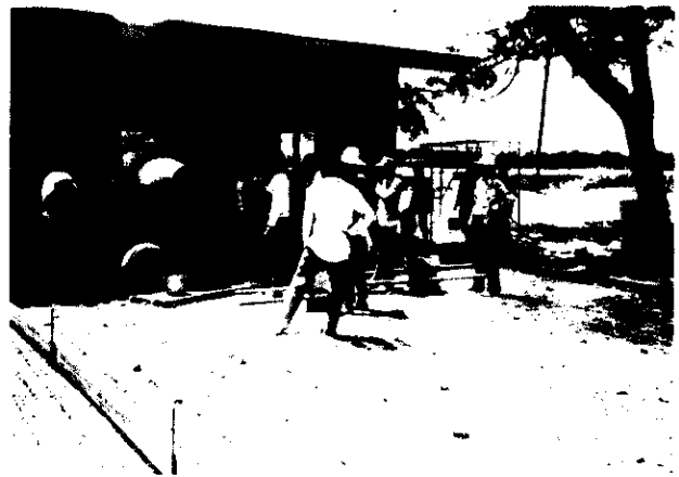
車庫・フロアコンクリート打設
