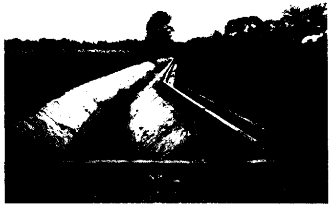
排水路NO. 3及び付替用水路
