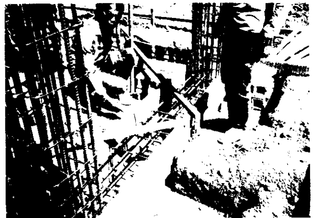
高架タンク基礎ビーム配筋
