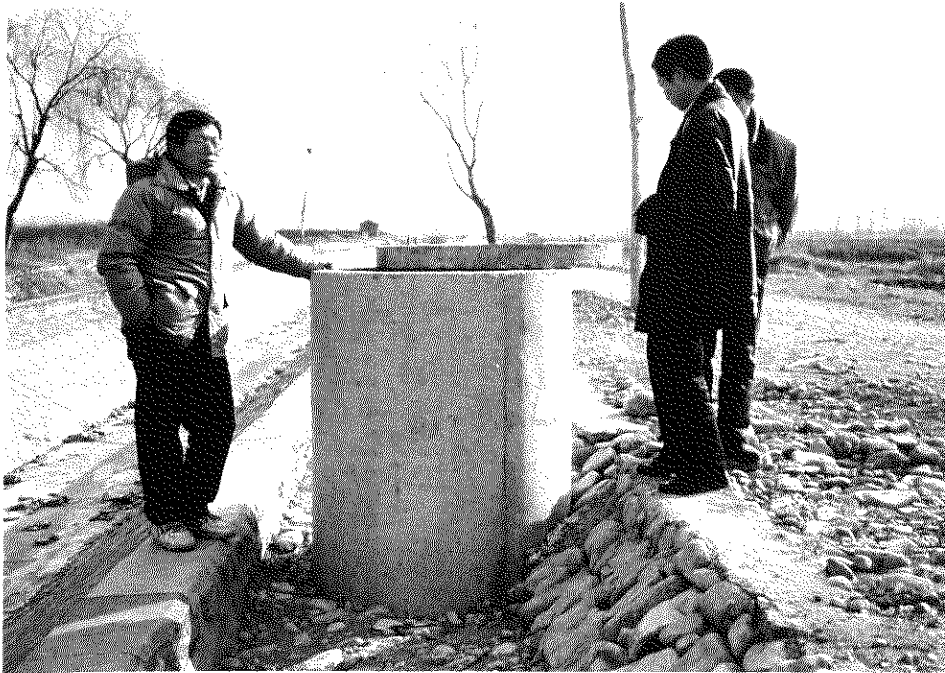
旧四支線制水子局 水位計用井戸 （ゲート上流側）
