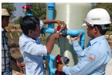
写真 2-3-11 施工時の様子
