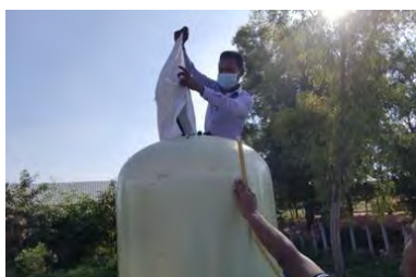
写真 2-3-10 施工時の様子
