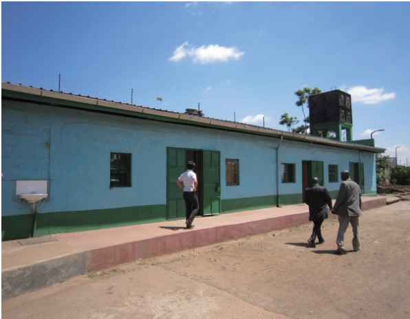
施設が整備されたカロレニ清掃事務所 (カロレニ清掃事務所、ナイロビ市)
