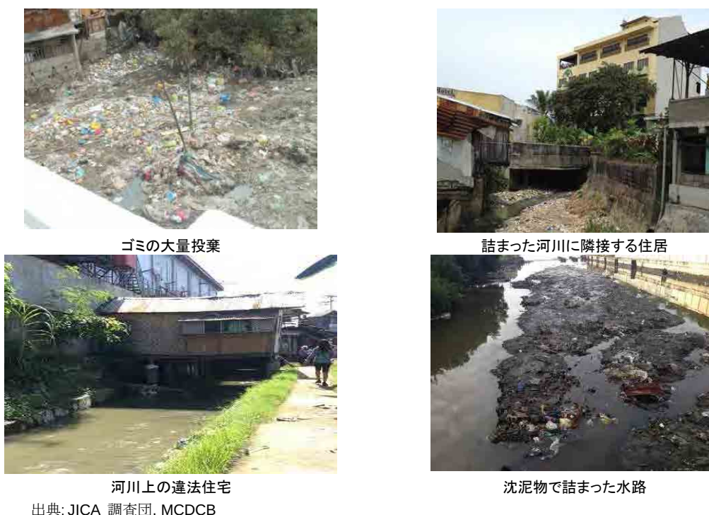
図 3.13 洪水の原因となる排水路の状況
