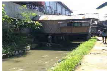
河川上の違法住宅
