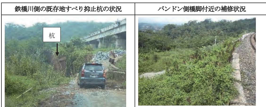
図 7.2-5 地すべり地点対策状況
