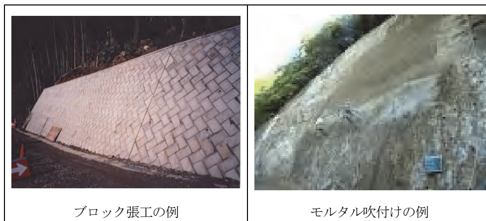
図 7.2-11 法面保護工の例
