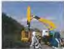
橋梁点検車を用いた維持管理実習
