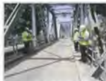
発見した損傷を記録する
