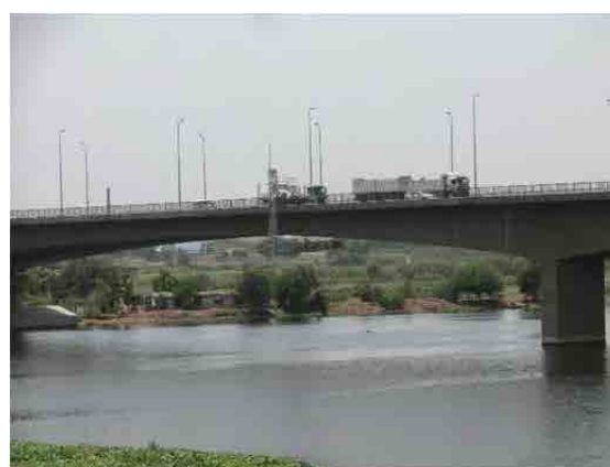
Inspection using BIV (Kafr El-Zayat Bridge)
