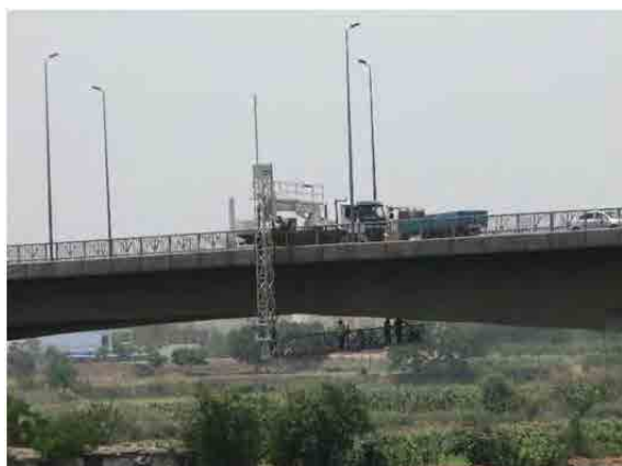
Inspection using BIV (Kafr El-Zayat Bridge)
