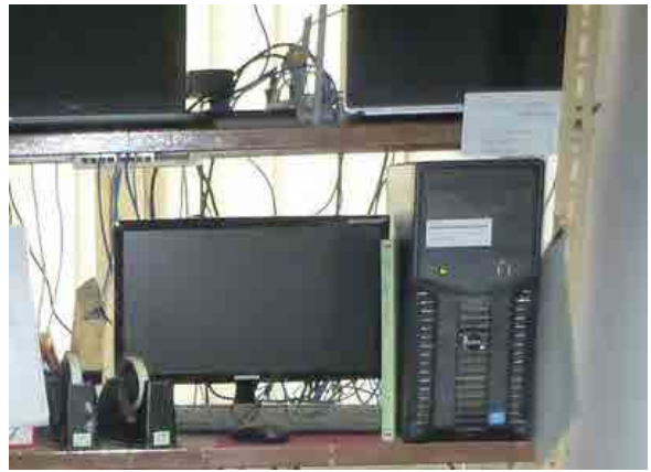
BMS サーバ設置状況
