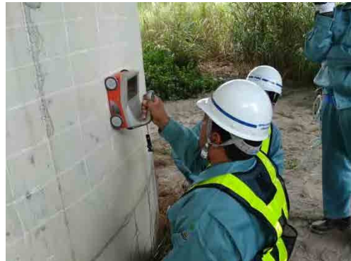
鉄筋探査計の実習
