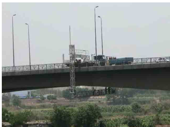
BIVによる点検状況 (Kafr El-Zayat 橋)
