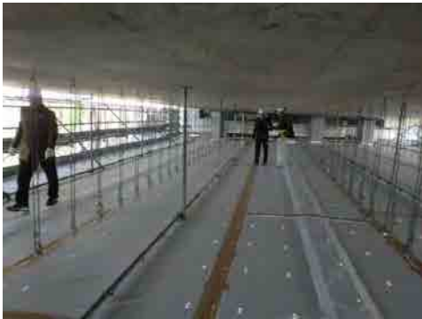
補修工事用足場を体験
