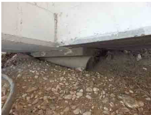
砂でほぼ埋まっている支承を確認して、維持管理の必要を説明する。
