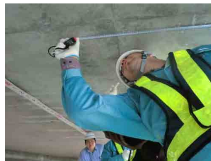
コンクリート橋の点検実習
