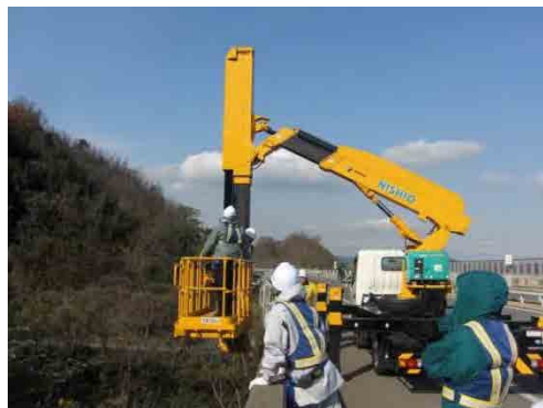
橋梁点検車を使った点検訓練
