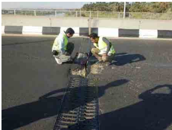
金具が外れたままで放置されている伸縮装置の損傷を確認し、損傷判定を実施。
