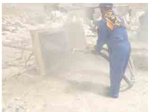
写真 2-7 ショットクリート工法の OST
