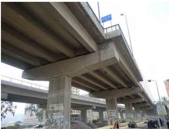
写真 2-3 建設時の片づけが不十分な事例
