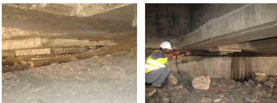
写真 2-8 支承周辺の土砂の堆積と高圧水洗浄機での洗浄
