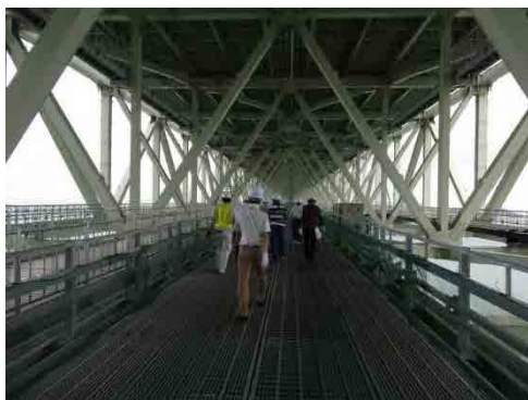
明石大橋の検査路視察
