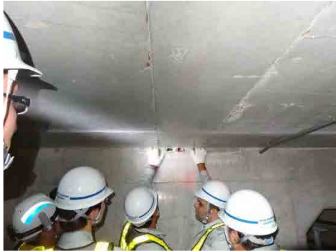
コンクリート橋の点検実習
