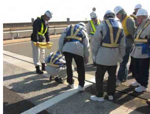
伸縮装置の点検実習
