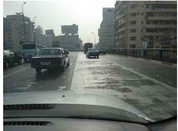
写真 2-2 鋼床版の舗装が消滅している事例
