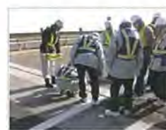
伸縮装置の点検実習
