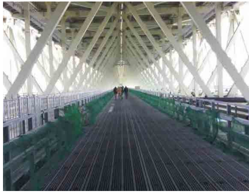
明石大橋の点検施設を視察
