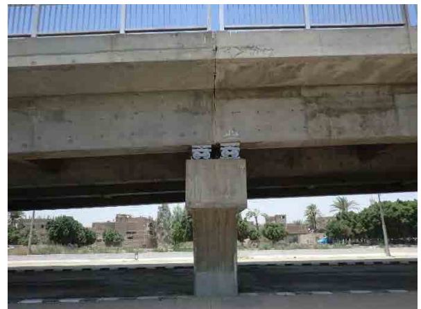
写真 2-4 建設方法の改善が必要な事例
