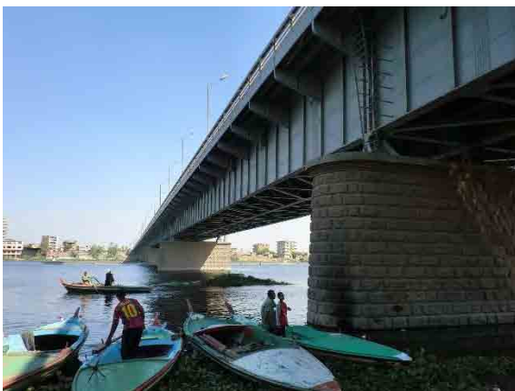
写真 2-5 良好な古い鋼橋
