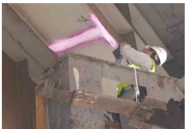
溶接線での浸透探傷試験
