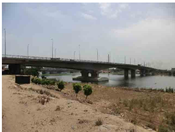
Kafr El-Zayat 橋 側面写真
