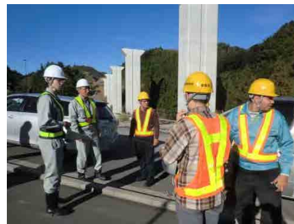
橋梁建設現場を視察
