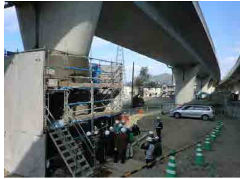
橋梁補強工事の視察
