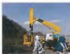
橋梁点検車を用いた維持管理実習
