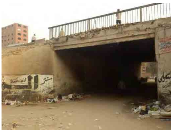
写真 2-9 補修工法デモンストレーションを行ったボックスカルバート
