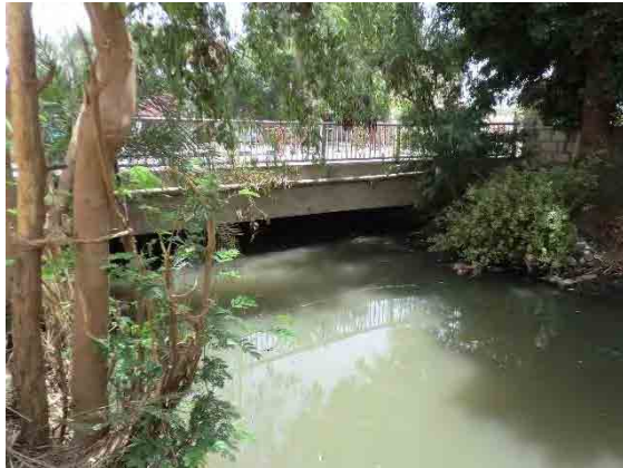
写真 2-1 桁下が低い事例
