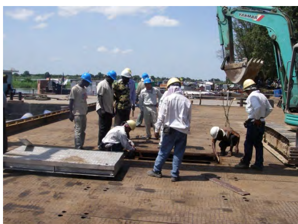
写真-3 覆工板取り換え作業換風景 (撮影：田中専門家)
