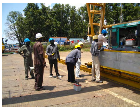
写真-4 クレーンリモコン取り換え風景 (撮影：今中専門家)
