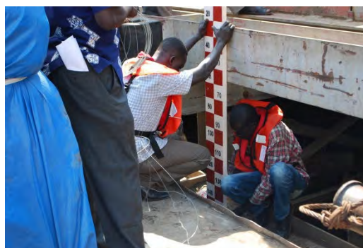
写真-2 設置状況
