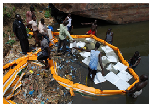
写真-6 オイル吸着マットによる 流出油の回収
