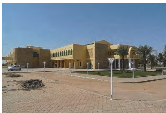
□既存総合病院棟の様子（2015年2月） 2階建、延床約7,100㎡。2015年2月現在も改修工事中で外装はほぼ完了。今後、3月に機材搬入据付の予定。
