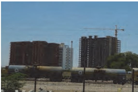
□ハルツーム中心部の高層住宅建設現場 建設現場は多くみられるが、進捗は大変ゆっくりである。単管足場は組まれるも、防護ネットの有無は現場ごとに異なる。
