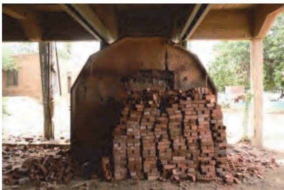
□レンガ 現地建設の主要材料はレンガで、コンクリートブロックは少ない。レンガはナイル川沿いの土を原料に製造される。
