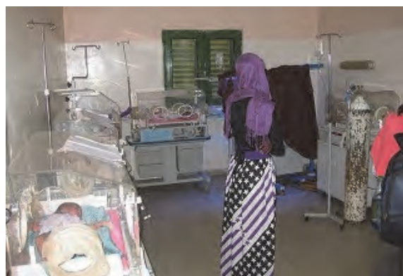
□トルコ総合病院 新生児室 壁沿いに隙間なく閉鎖式保育器を配置し、医療ガスの配管は無し。特に清潔区画はなく、外気が入り込む状況。
