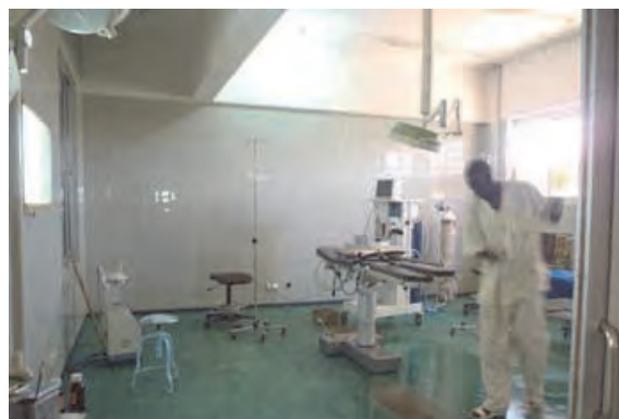
□アルサウジ母子病院 手術室 壁はタイル、床はビニール系シート張り仕上げ。概ね清潔に良く維持管理されている。
