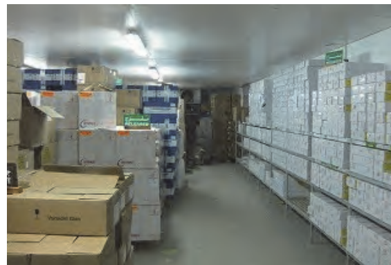
□中央医薬品センター 医薬品の管理倉庫。徹底した温度や清掃の管理に加えて、入出庫やロケーション管理等とも連動している。
