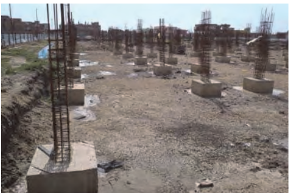
□公立総合病院の基礎工事現場 設計では直接基礎であったが、地盤が悪く、現場打RC杭基礎に変更された。
