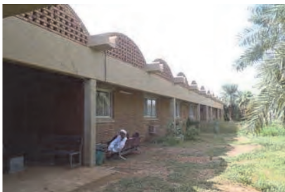
□アルサウジ母子病院 外観 1986年に建設。プレキャストコンクリートの柱・梁とレンガ積の壁で構成されたプロトタイプの産科病院建築である。
