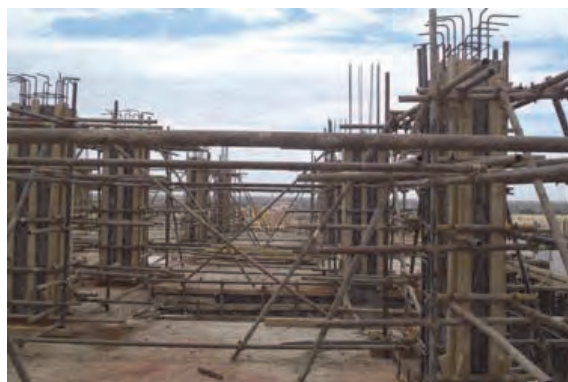
□鉄筋コンクリート柱打設の様子 型枠にコンパネと単管が使われ良好な工事。スラブ打設は日射の影響を避けるため、早朝または日没後に行う。
