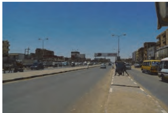
□ハルツーム中心部の幹線道路 複数車線の道路は状態良く車両の往来は多い。雨水側溝がなく、降雨時の水はけが悪い。
