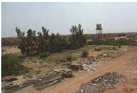
□対象サイト建設用地の様子 140m×40mのほぼ平地である。本体工事開始前に既存建物、舗装タイル、縁石や樹木の撤去が必要。
