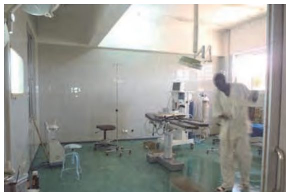
□アルサウジ母子病院 手術室 壁はタイル、床はビニール系シート張り仕上げ。概ね清潔に良く維持管理されている。
