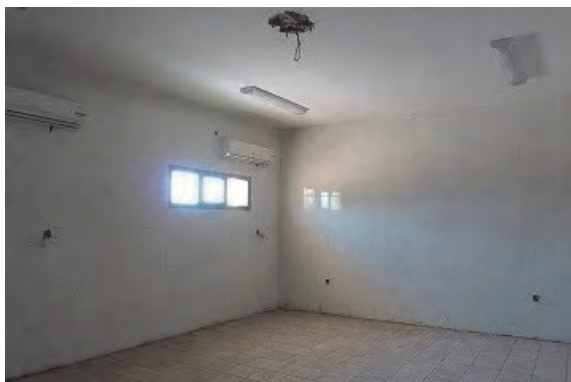
□既存手術室の様子（改修中） 手術室は計3室あり、外科手術を目的としている。床および壁はタイル仕上げ。サニタリーコーナーは配慮なし。
