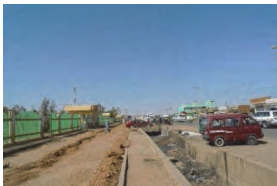
□ウンバダ総合病院前面道路の様子 南北に走る幹線道路で、病院敷地との間に雨水排水溝有り。道路状態は良好で交通量は多い。
