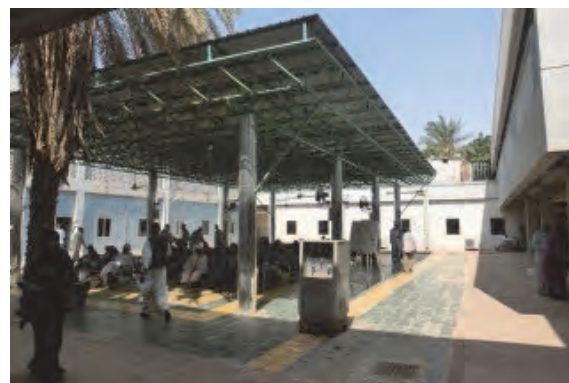
□イブンシーナ病院 待合スペース 1983年に本邦無償資金協力により設立。暑い気候から大人数の集まる待合はオープンエアとするケースが多い。
