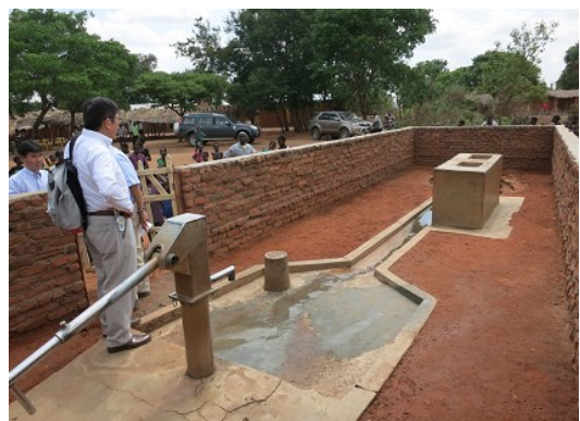
改良された給水施設(研修後)
