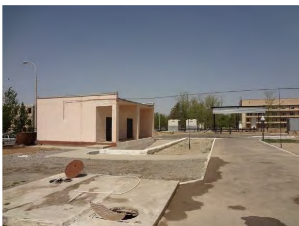
NRMMC 酸素供給棟および冷暖房設備
