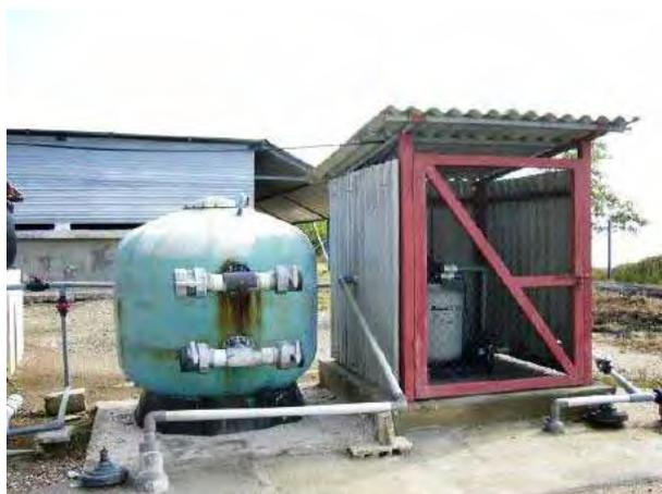
海水の取水システムに導入された小型の砂ろ過機
