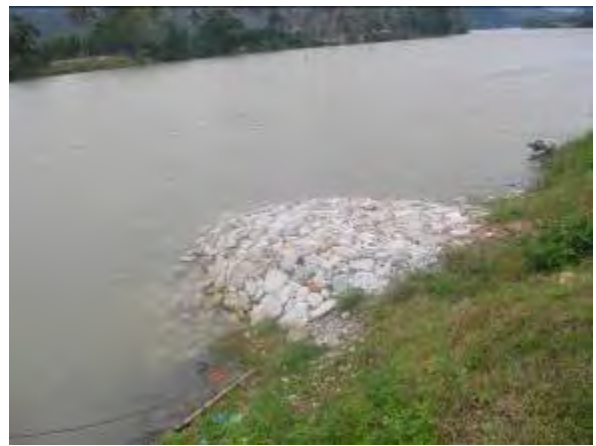
パイロット・プロジェクトで建設した水制工
