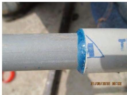
Nota: La rebaba genera cierto tipo de membrana. Esta se debe eliminar sin falta, se debe prevenir la formación de dicha membrana.
