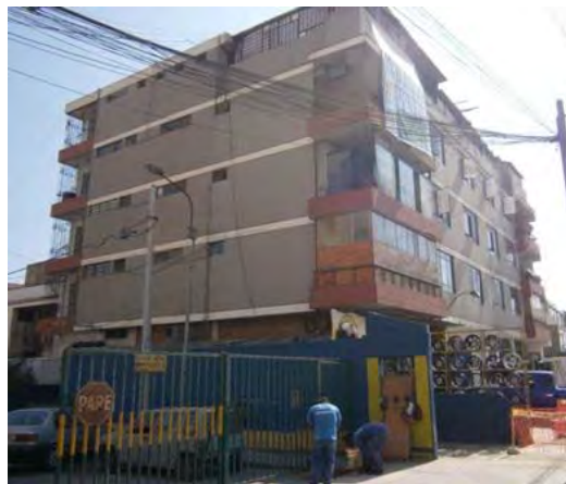
盗水のあったビル
