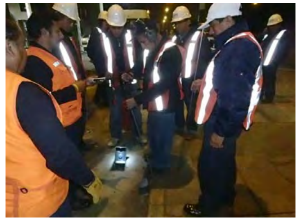
漏水探知作業(夜間)
