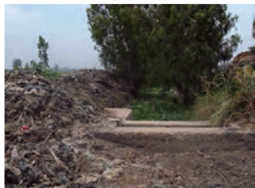
写真 18 候補地 No5 Irrigation 水路
