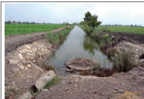
写真 32 候補地 No9 Irrigation 水路(通水時)
