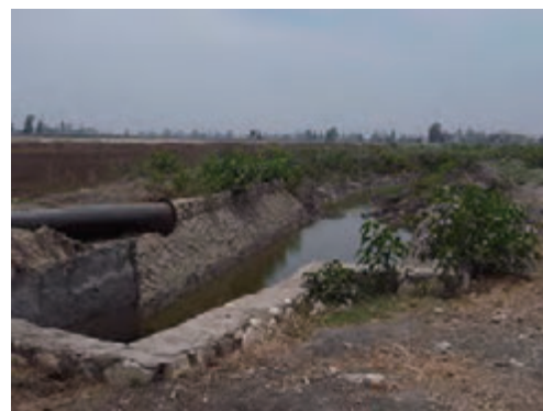
写真 2 候補地 No1 Irrigation 水路
