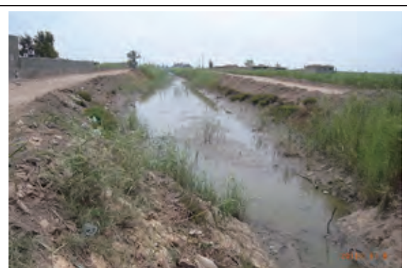
写真 10 候補地 No3 Irrigation 水路
