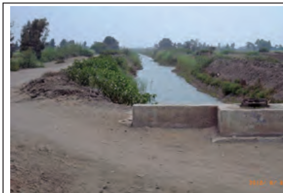
写真 13 候補地 No4 Irrigation 水路
