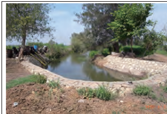
写真 25 候補地 No7 Irrigation 水路
