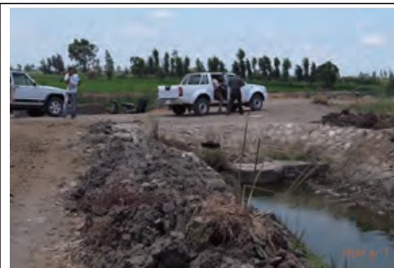
写真 28 候補地 No8 Irrigation 水路
