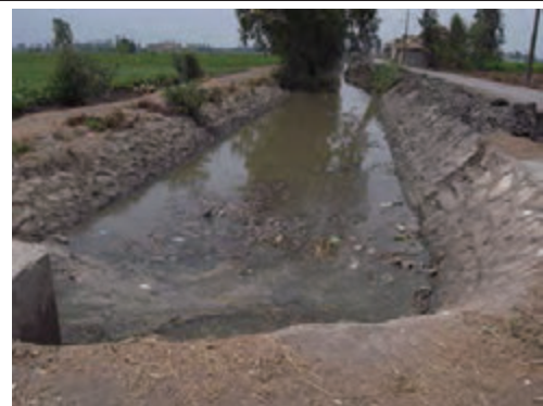
写真 6 候補地 No2 Irrigation 水路
