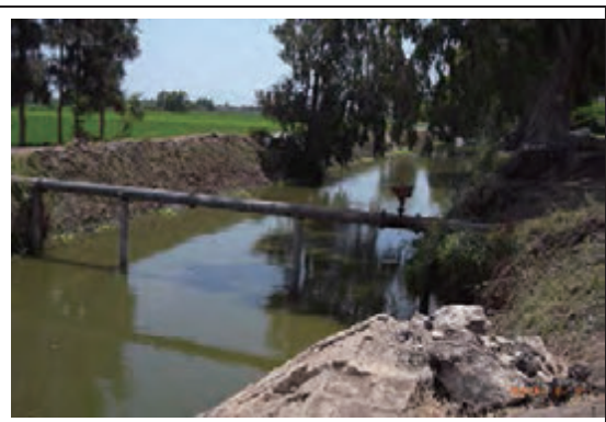
写真 22 候補地 No6 Irrigation 水路
