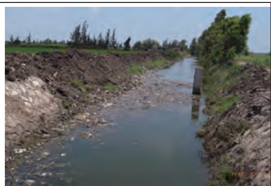
写真 29 候補地 No8 Irrigation 水路
