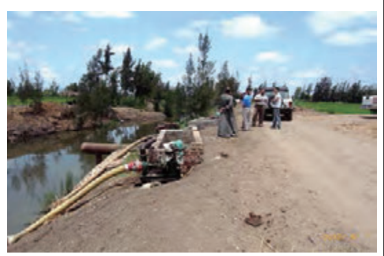
写真 35 候補地 No9 Drainage 水路(断水時)
