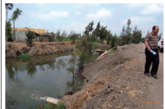
写真 34 候補地 No9 Drainage 水路(通水時)
