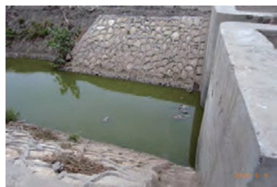
写真 14 候補地 No4 Irrigation 水路
