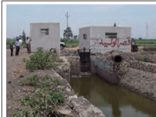
写真 1 候補地 No1 Irrigation 水路
