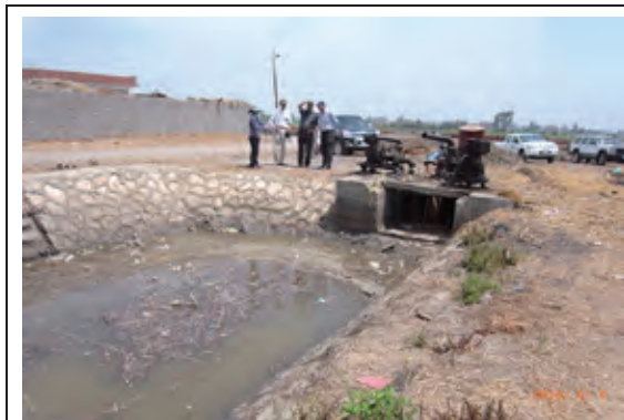
写真 5 候補地 No2 Irrigation 水路
