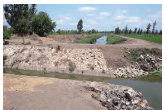
写真 24 候補地 No6 用水路と排水路.
