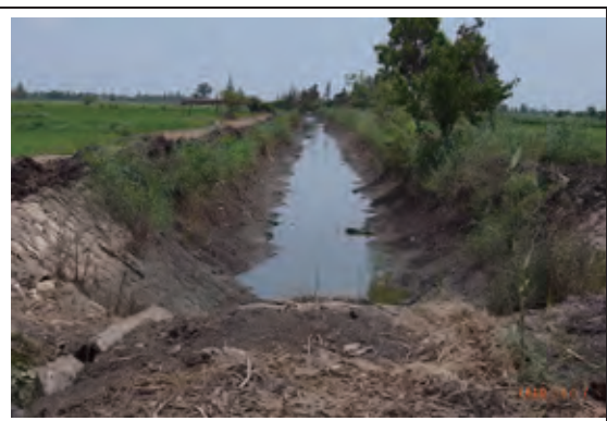
写真 33 候補地 No9 Irrigation 水路(断水時)
