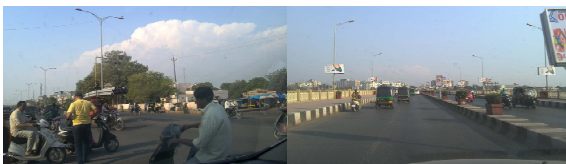
図 2-6 新市街の道路 (左) とタプティ川にかかる橋 (右)
