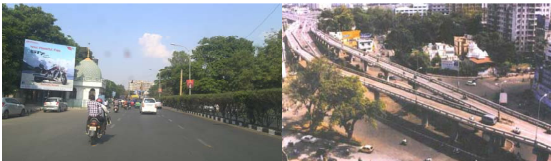
図 2-7 スーラト市の Ring Road (左) と高架道路 (右)
