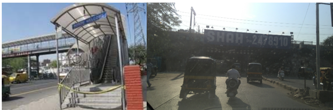
図2-13 主要道路に建設される歩道橋と現地の屋外広告で過半のシェアを持つShah Publicity
