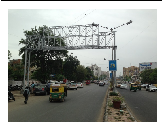
交通情報板ガントリー設置完了 (2014年10月)
