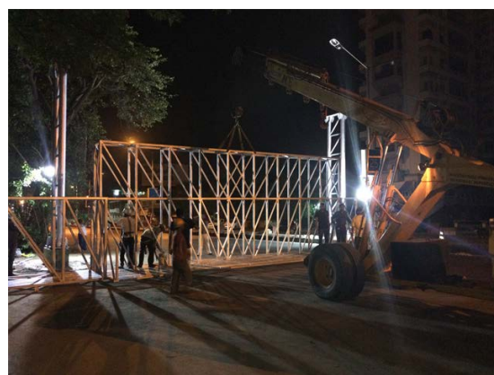
図 26 設置中の交通情報板ガントリー
