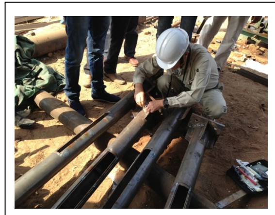
カメラポール溶接確認作業 (2014年7月)
