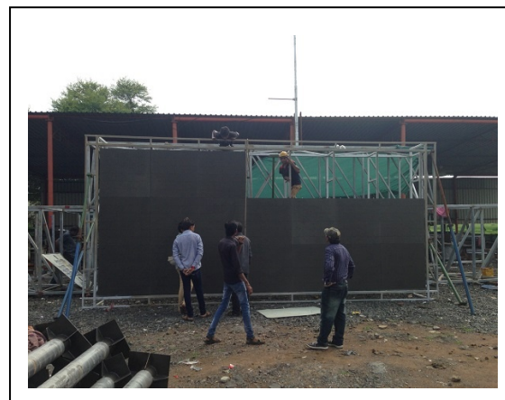
交通情報板組立作業 (2014年8月)
