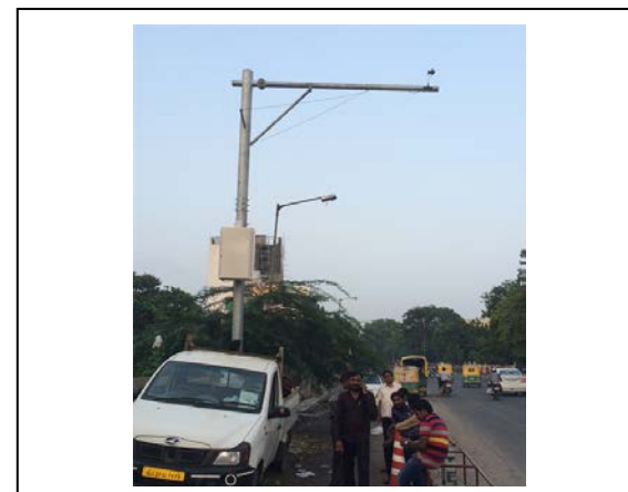
交通渋滞センサー設置完了 (2014年9月)
