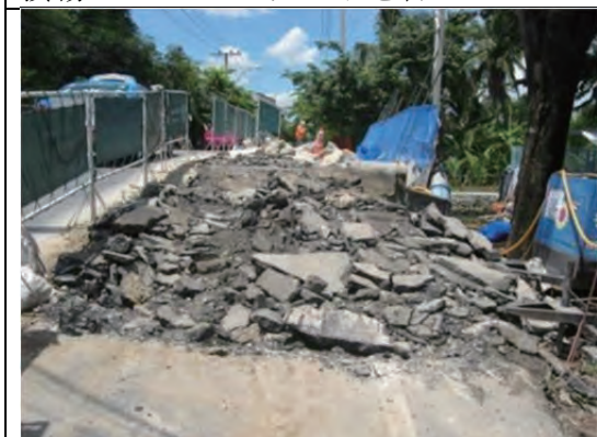
損傷したスラブを撤去
