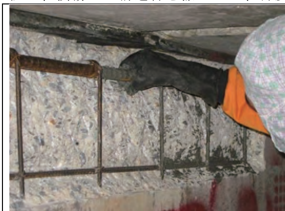
損傷したコンクリートを除去
