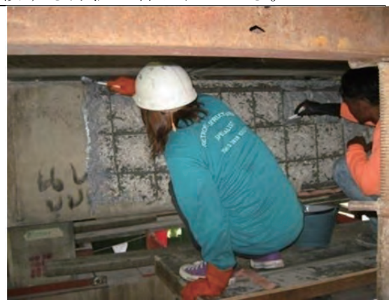
モルタルで補修
