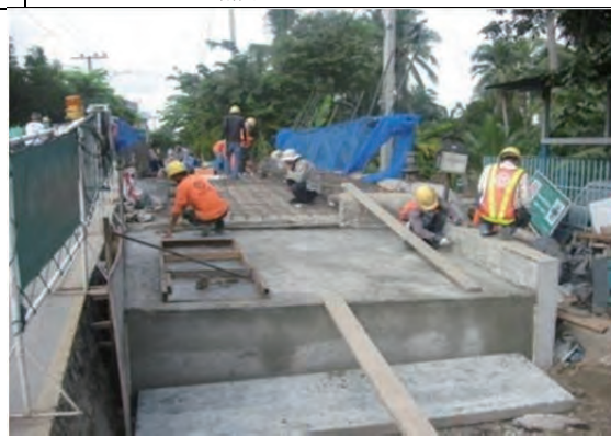
スラブを新設
