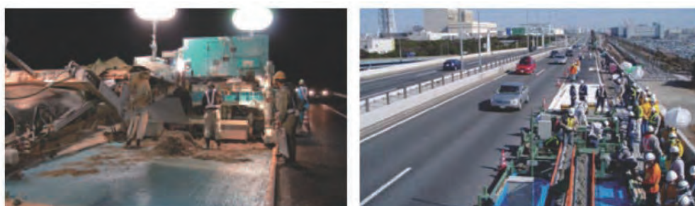
図 129 高架橋床版上面での塗布実施例
