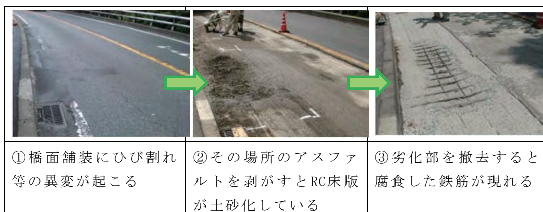
図 123 RC床版の劣化イメージ
