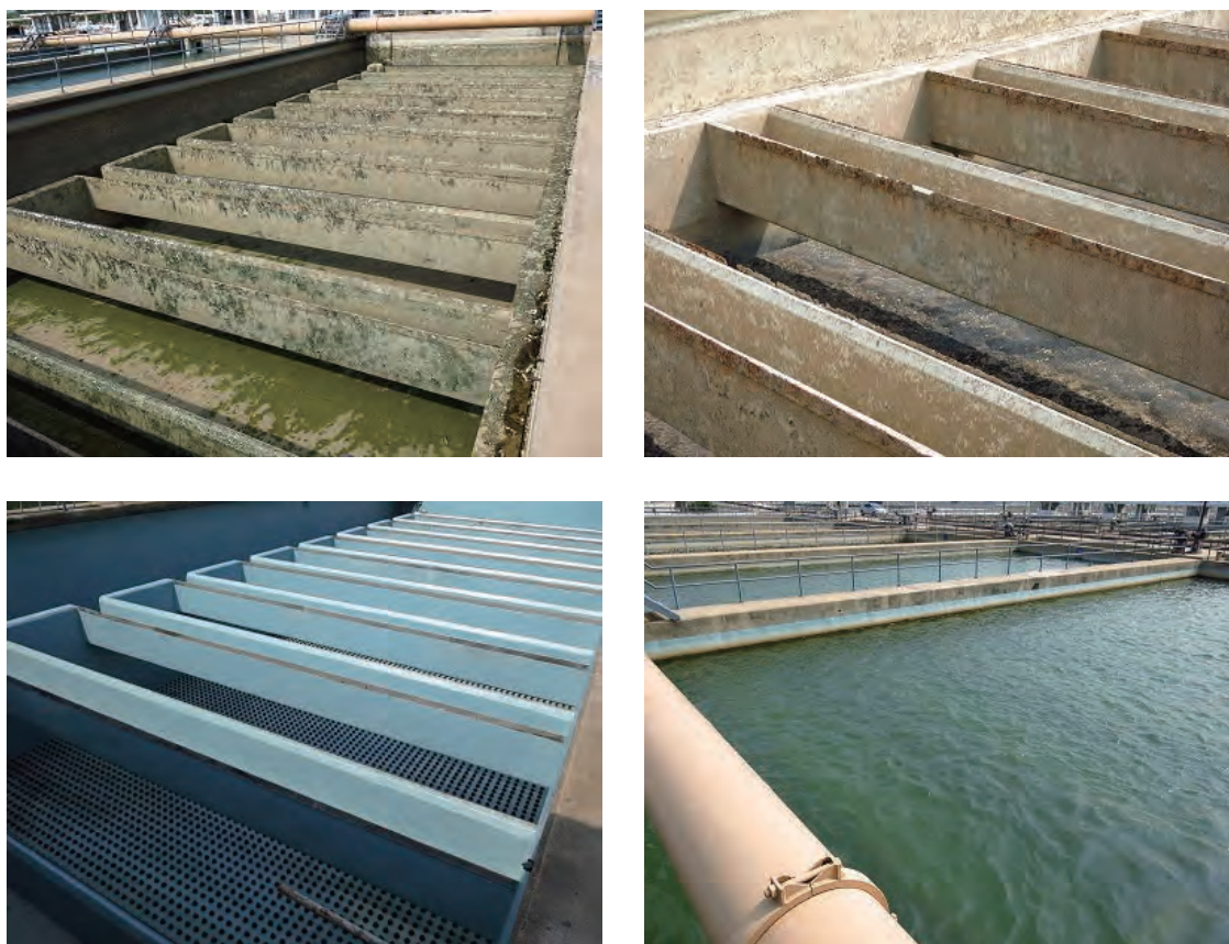
図 83 急速濾過池の修理前(上)と修理後（下）
