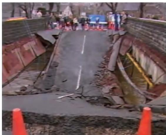
図 30 PC鋼材の破断による落橋<sup>25</sup>
