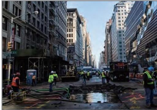
図 26 水道管破裂による道路陥没（2014年1月15日）<sup>19</sup>
