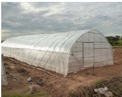
写真：現地部材で試作したネットハウス
