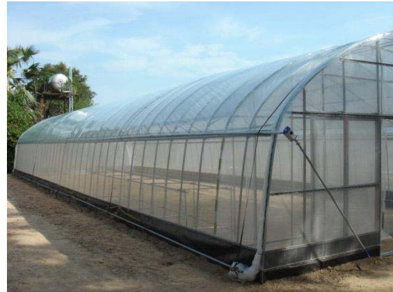
写真：雨除けシートを巻き下ろした状態
