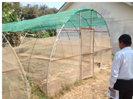
写真：隙間・錆のできた GH (MAFF 試験場)
