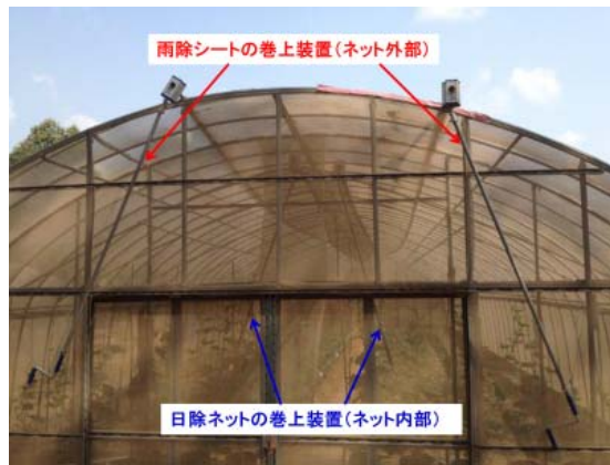
写真：雨除シートと遮光ネットの巻上装置
