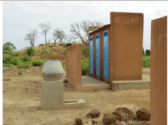
既存中学校 生徒用トイレ棟 男女別のトイレ棟と手洗い用の水がめ。学校敷地内の井戸から水を運ぶ。 (中央州カディオゴ県ボンソンティンガ中学校)
