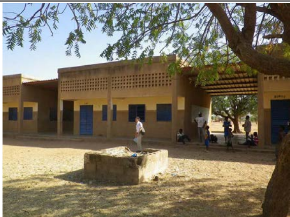
プラン・ブルキナファソの小学校 プランの小学校は、標準設計ではなく、教室と教室の間に 屋根のある半屋外空間のある独自のデザインを採用 している。(中央北部州サンマテンガ県ファンカ小学校)
