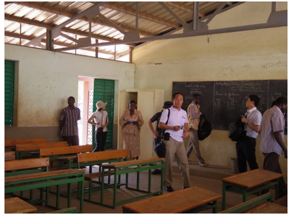
一般無償「第三次小学校建設計画」 壁上部の明り取り+換気窓が効果的で、室内環境は快適 である。教室内の清掃など維持管理が行き届いている。 (中央プラトー州クエゴー県ライ小学校)
