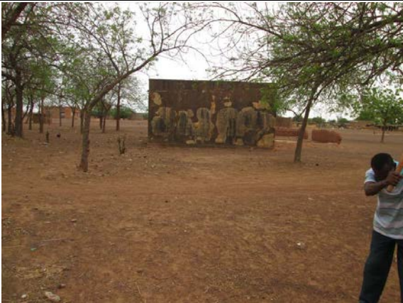
A-27 トウグリ カヤから65km、舗装された幹線道路沿い。中学校予定位置に老朽化した教員住宅があるため、相手国負担工事として撤去予定。
