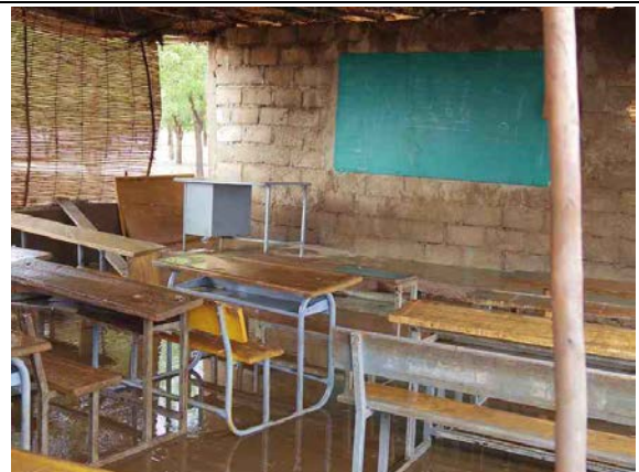
既存小学校の仮設教室 屋根・壁が草ぶきであるため、雨が降ると教室内が水浸しとなる。同敷地内に中学校を建設する。 (中央北部州サンマテンガ県マルー小学校)
