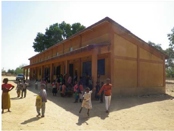
一般無償「第一次小学校建設計画」 竣工後 20 年が経過し、経年変化による傷みはあるが、 学校により良好に維持管理されている。(中央プラトー 州ガンズルグー県カンバンボリ AB 小学校)
