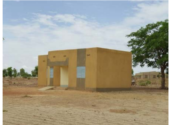
既存中学校 管理棟 標準設計の管理棟は、校長室、秘書室、経理室、倉庫で構成され、教員室、教務員室は教室棟に組み込まれている。 (中央州カディオゴ県ティンガンド中学校)
