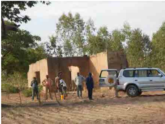
A-07 バルキィ A 中学校教室棟の建設予定位置には老朽化した2棟の教員住宅がある。相手国負担工事として撤去予定。
