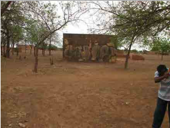
A-27 トウグリ カヤから 65km、舗装された幹線道路沿い。中学校予定位置に老朽化した教員住宅があるため、相手国負担工事として撤去予定。
