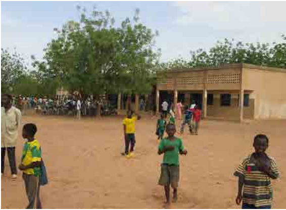
A-25 ファンカ カヤ近郊のサイトで、カヤからのアクセスは全て未舗装(13km)。既存小学校校舎の1棟はPLANブルキナによる。
