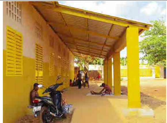
コミ開無償「第五次小学校建設計画」 長廊下の代わりに設けられたテラスが、強い日差しを遮 り、快適な半屋外空間を創出している。 (オーバッサン州ウエ県ウエザンビラーD 小学校)
