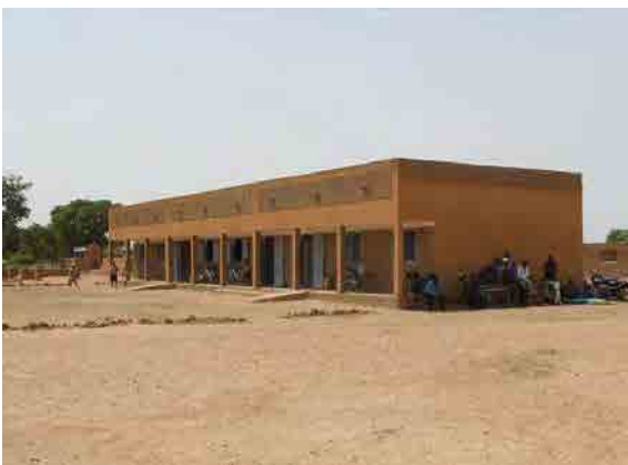
A-29 ボコ 既存小学校校舎のうち1棟はアフリカ開発銀行による建設(2012年)である。
