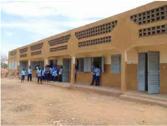
p 既存中学校 教室棟外観 現地政府により建設され2012年に開校した中学校。現地標準設計に基づき建設されている。 (中央州カディオゴ県ティンガンド中学校)
