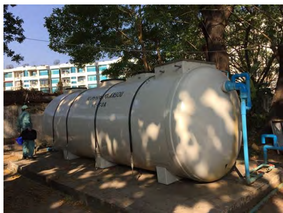
[現場写真] 既存浄化槽（YCDC 訓練校）
