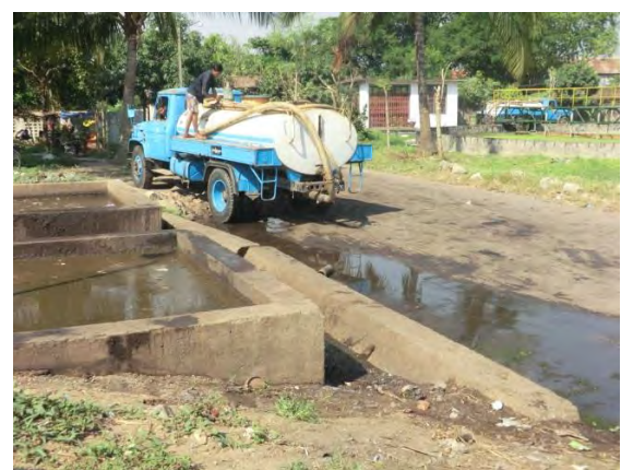
[現場写真] 腐敗槽汚泥搬入状況
