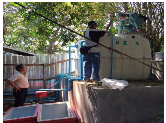
〔現場写真〕 既存浄化槽（ガンドーギー湖脇レストラン）
