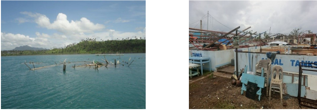
図 1.4-1 被災した魚囲い（バセイ町）（左）と被災したギワン水産試験センター孵化施設（右）
