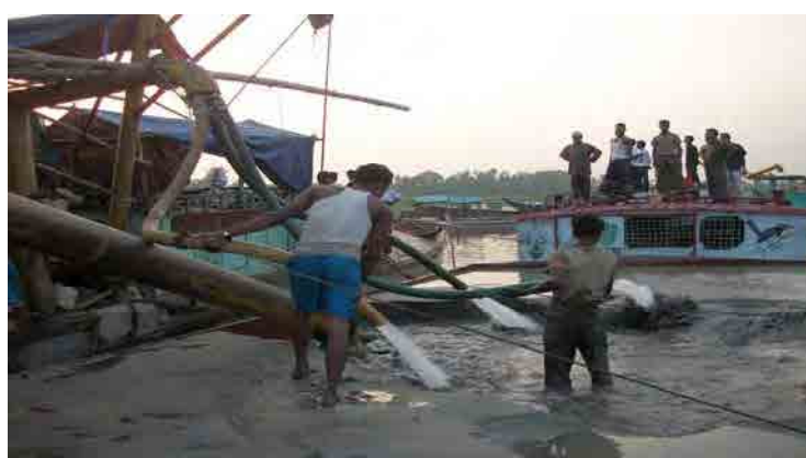
図 17.8-22 ローカル浚渫埋立状況
