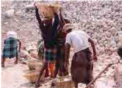
図 17.8-17 採石状況（人力） 提供提供：Khaja Construction
