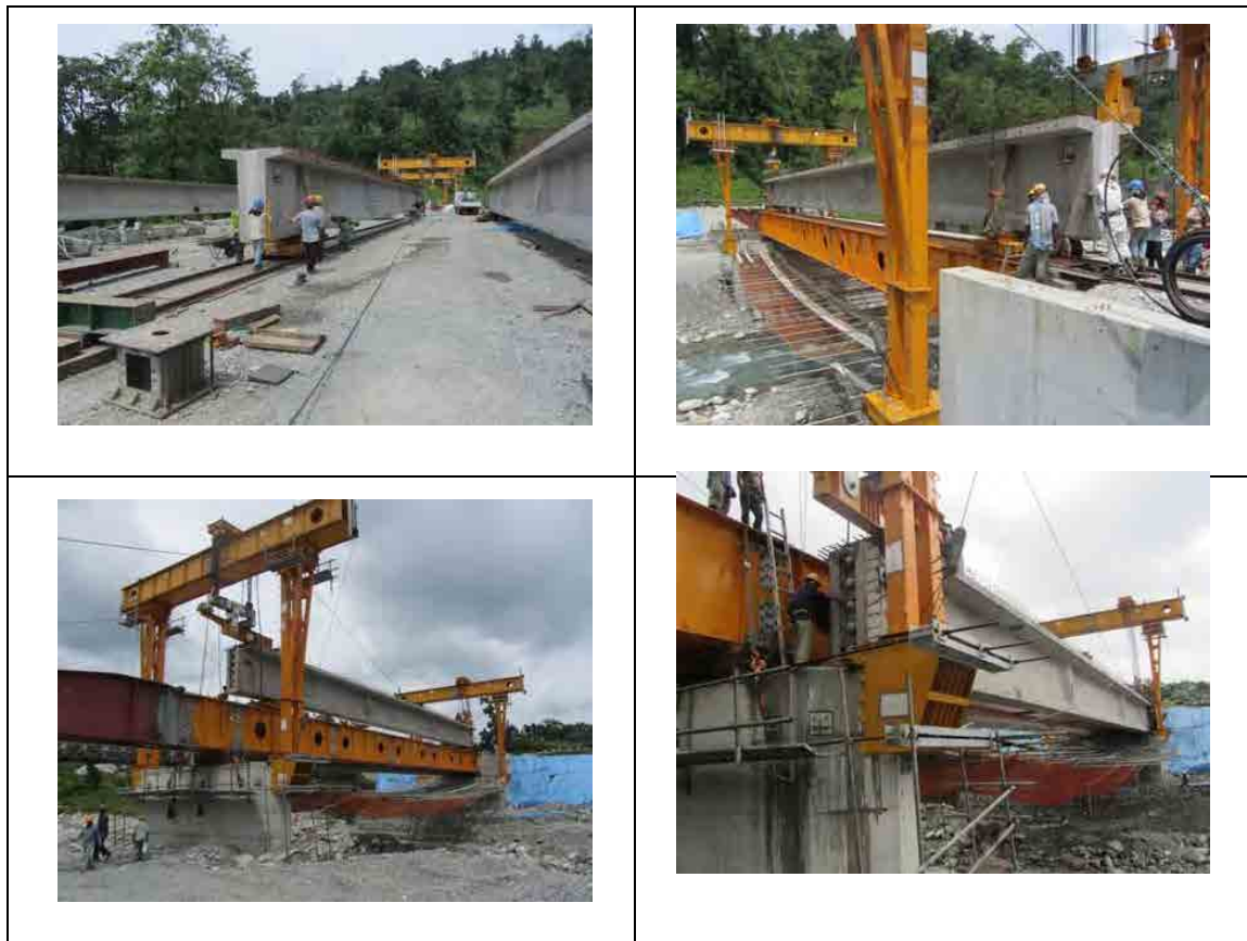
図 16.4-9 エレクションガーダー工法の参考図
