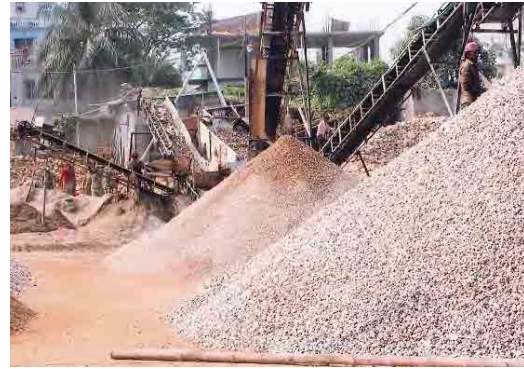
図 17.8-18 碎石製造状況 写真提供：Khaja Construction
