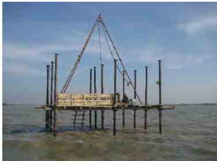
図 17.3-3 櫓式ボーリング
