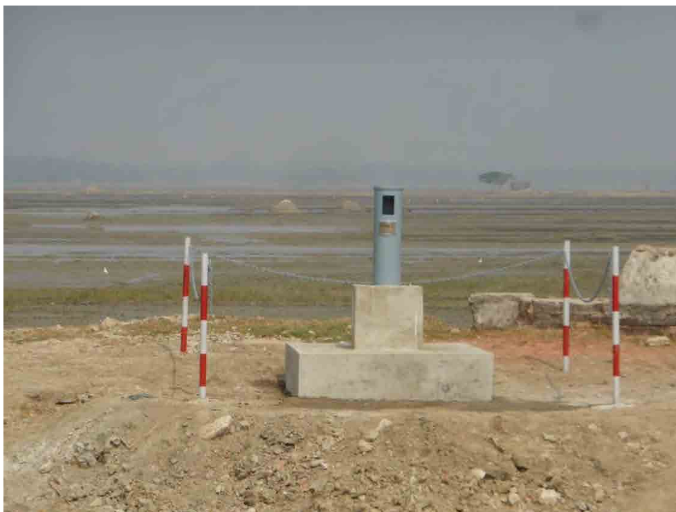
図 17.5-46 測量基準点の設置状況
