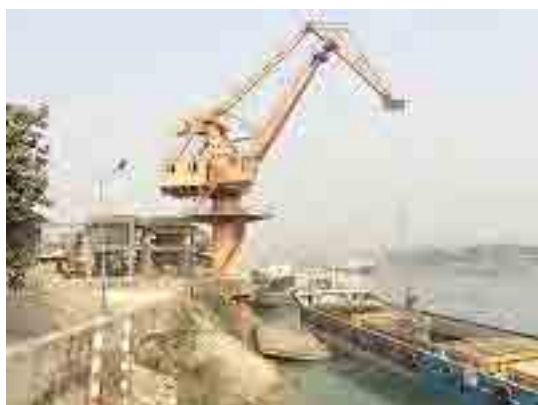
図 17.8-1 クリンカ荷揚げ状況
