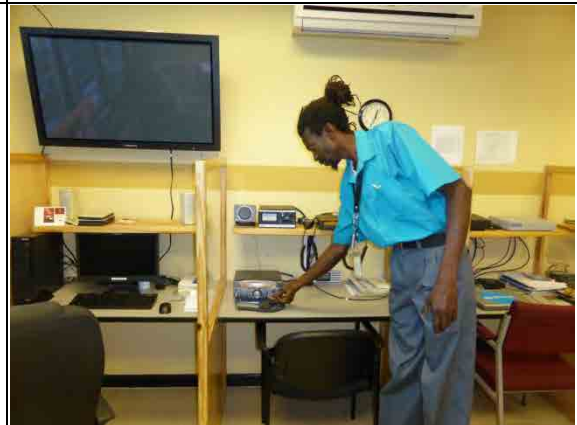
写真 2 8 ODPEM の情報通信室
