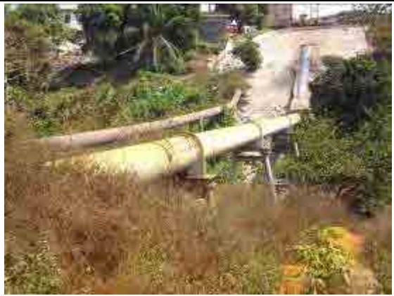
写真-2: FRPM 管始点の制水弁
