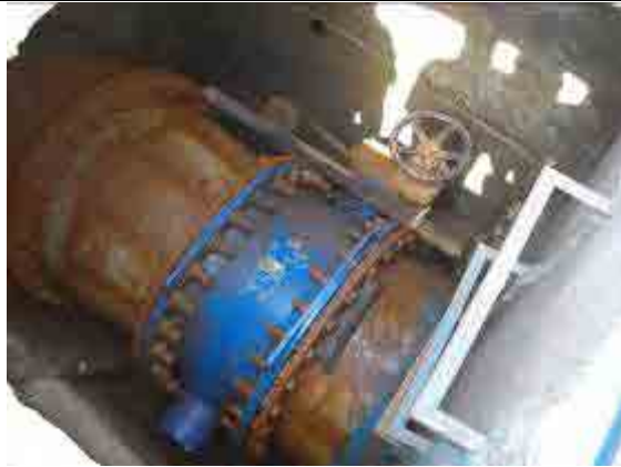
写真-2: FRPM 管始点の制水弁
