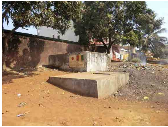
写真-1: FRPM 管始点部分のバルブボックス
