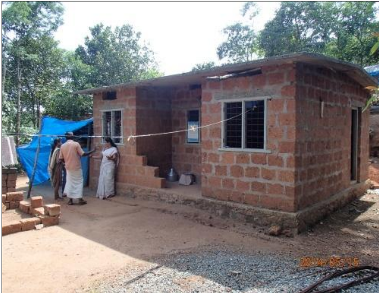
地方基盤整備: Thavinhal Grama Panchayatにおける 建設中の家屋
