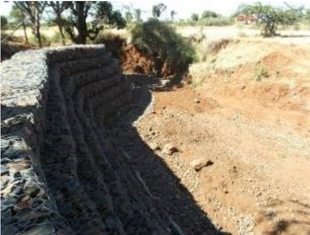
写真 3 : Isiolo サブ流域における Eastern Marania 川の護岸対策（パイロット事業）
