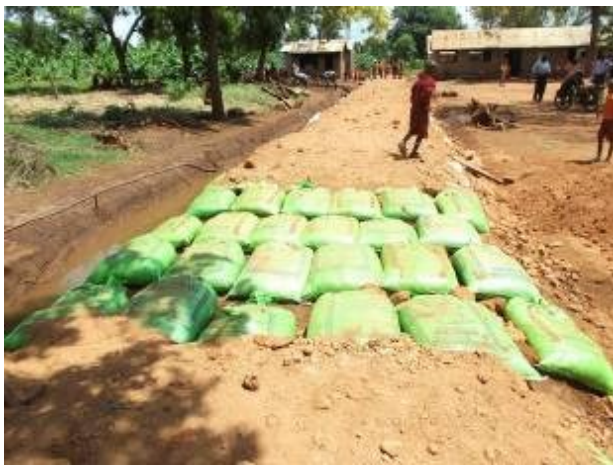
写真 5 : Lumi サブ流域における土嚢（Do-nou）を使った嵩上げ避難道路対策（パイロット事業）
