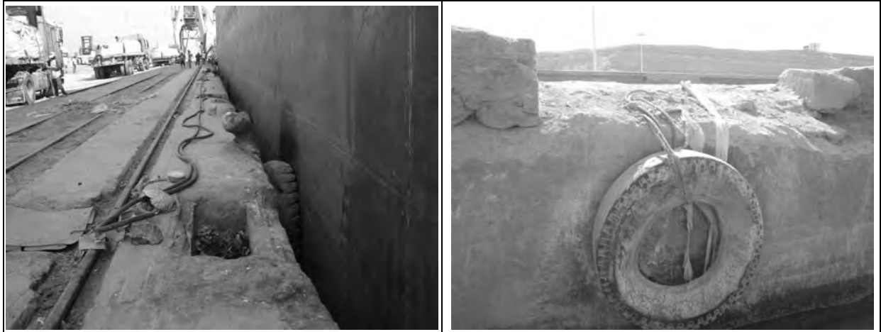
図-2-1-4-(1)-3 防舷材の状況
