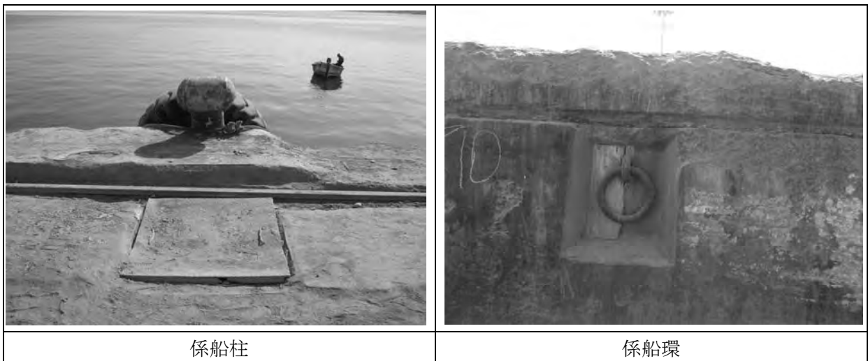
図-2-1-4-(1)-4 係船柱・係船環の状況
