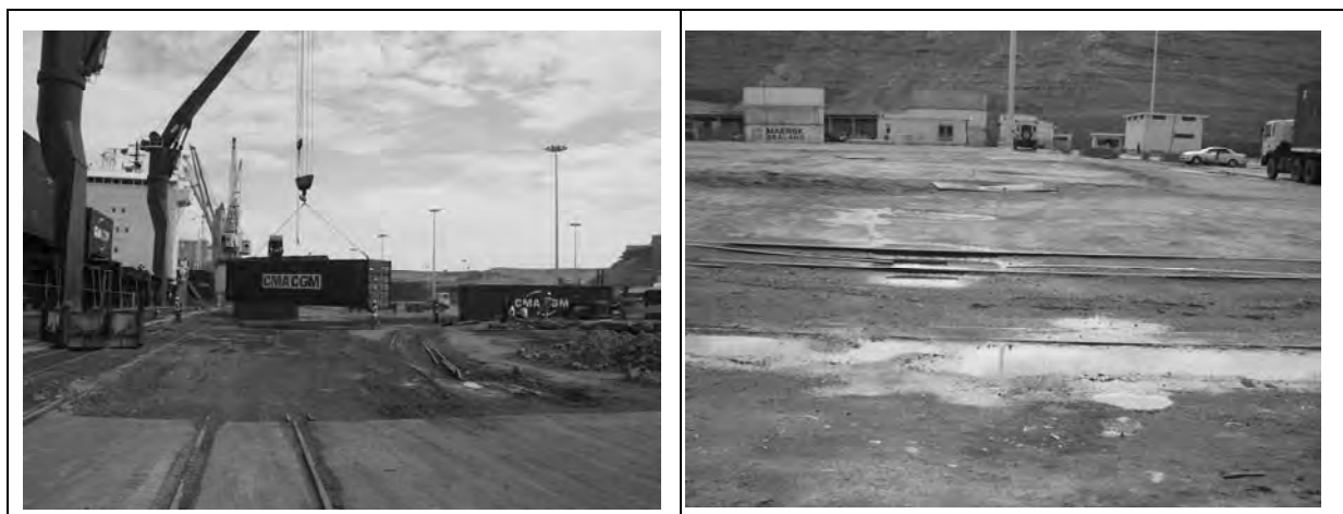
図-2-1-4-(2)-5 港内鉄道の状況
