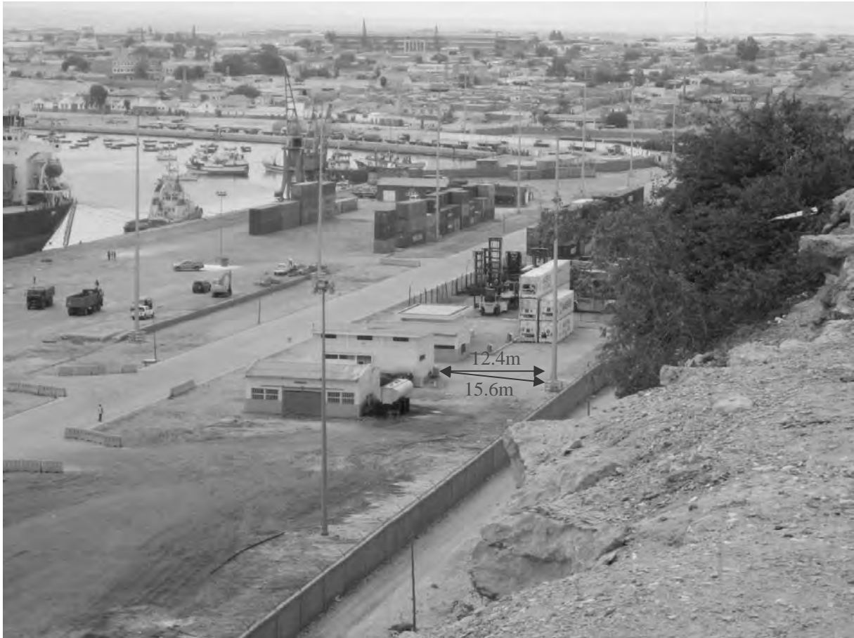
図-3-2-1-(1)-3 狭隘な冷凍コンテナ蔵置場所(写真)
