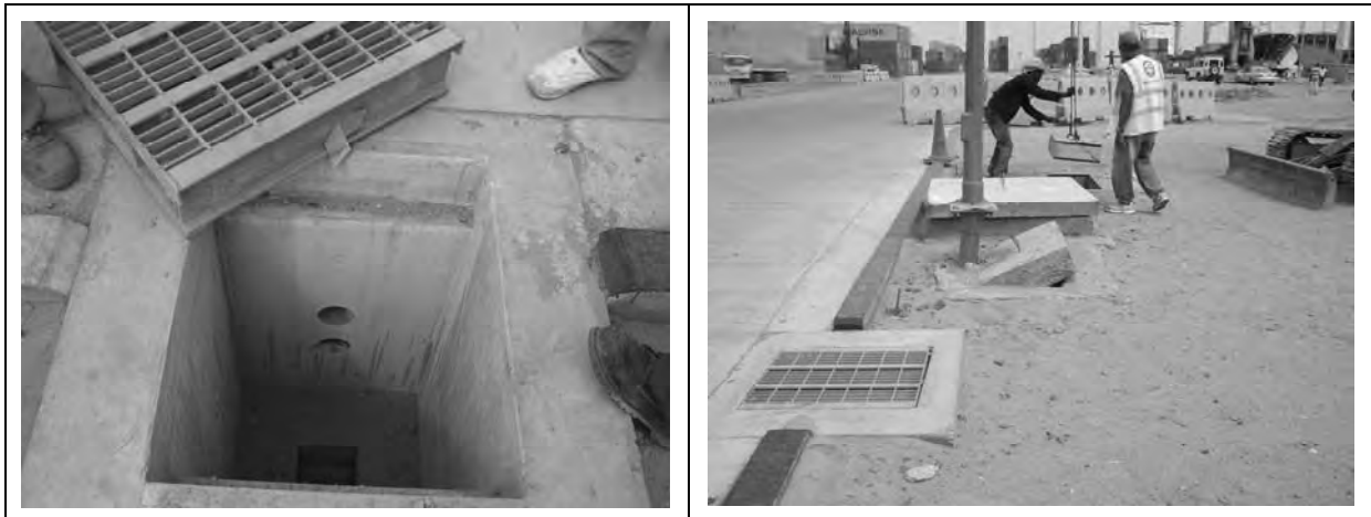
図-2-1-4-(2)-6 雨水排水施設の状況
