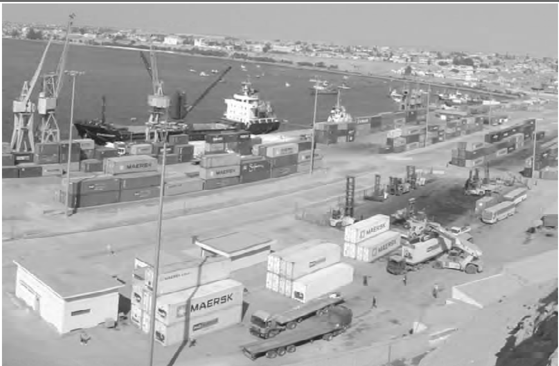
現況写真-3 ヤード現況
