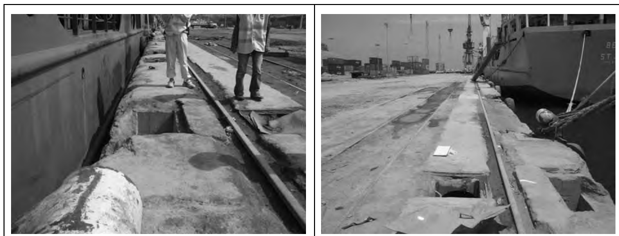
図-2-1-4-(1)-2 岸壁上部工の状況
