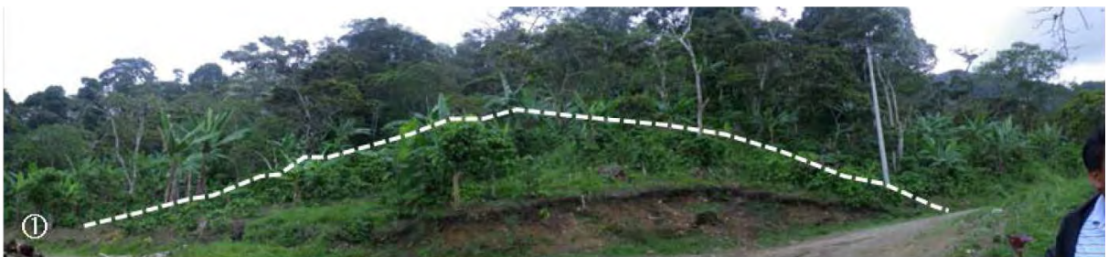
Fotografía 2-1 Precipitación que se observa en la parte superior del segmento de deslizamiento
