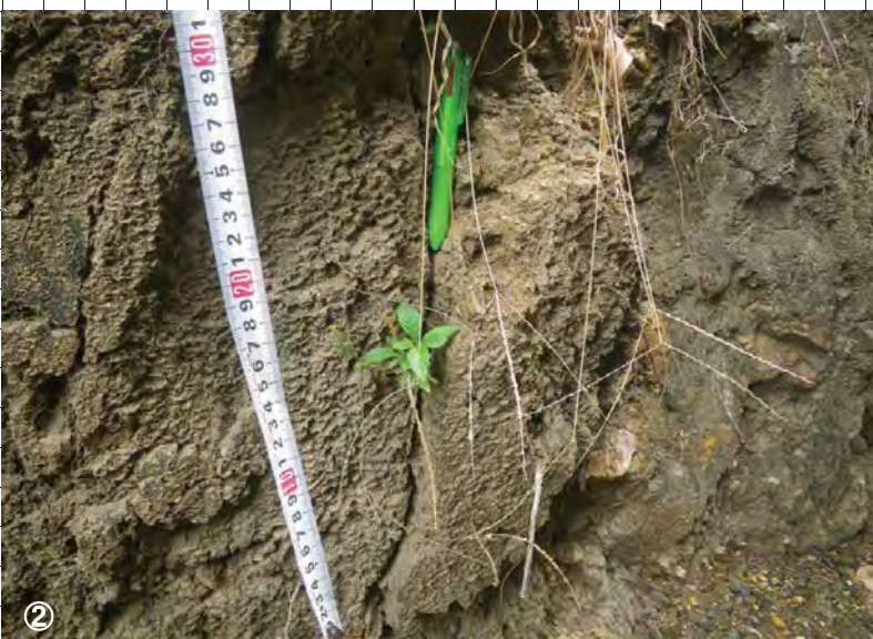
② 露岩は風化が進んだ変成岩で、開いたクラックが多数存在する。
