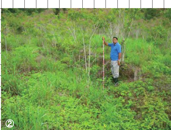
斜面からの水みちの状況 (深さ1m、勾配10度)
