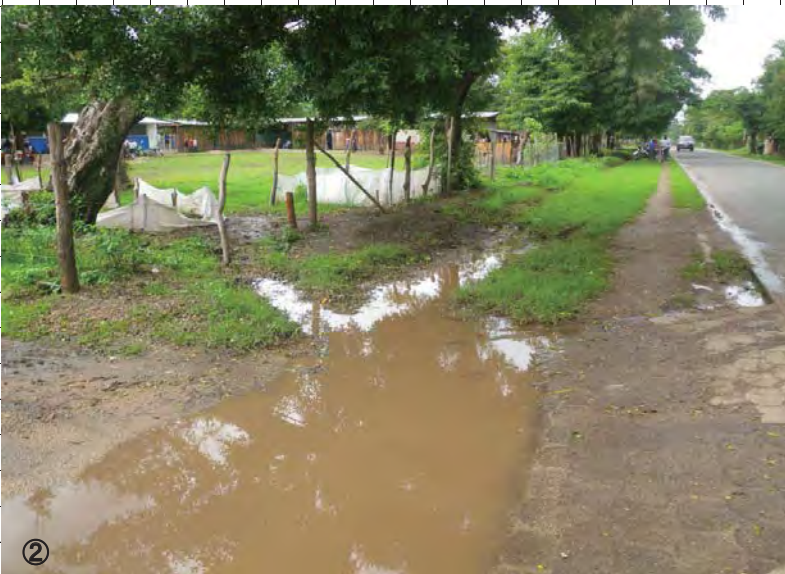
② 学校敷地からの雨水の排水状況
