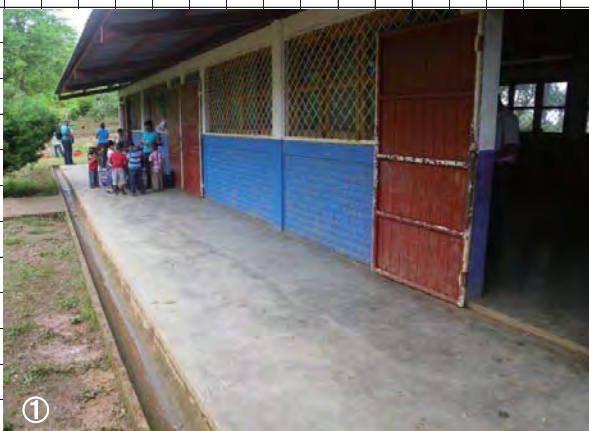
既存構造物にクラックや破損は生じていない。
