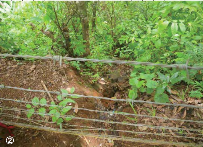
② 急峻な段丘崖への落水箇所
