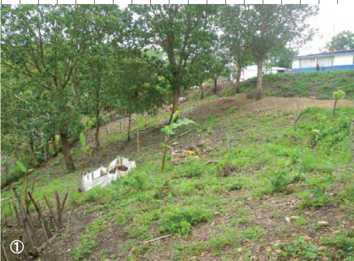
学校敷地東側の斜面の状況
