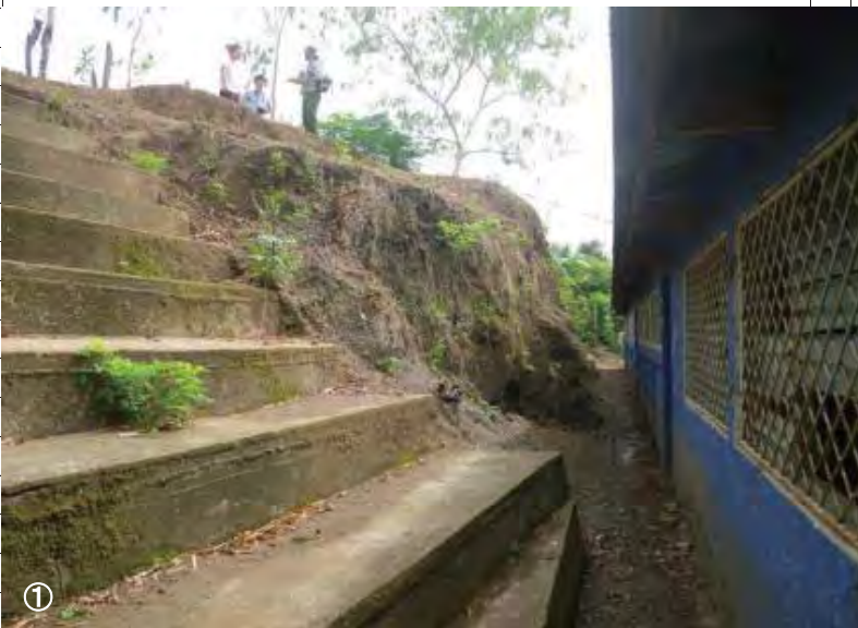
① 既存校舎に近接している急勾配の露岩
