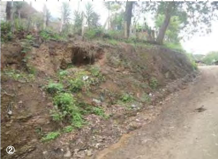
学校敷地西側ののり面の状況
