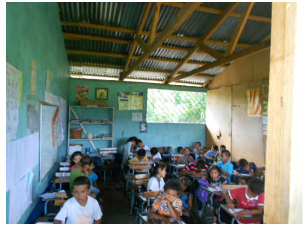
写真-25：教室の様子 1 教室を板で仕切って 2 教室として使用している。（ヌエバ・セゴビア県ハラバ市エル・フンコ、NS-27）
