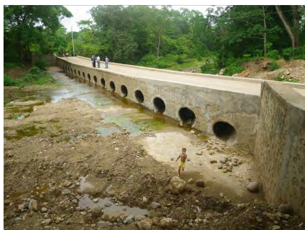
(NS2 インスティトゥート・トレス・デ・マルソ・テルヌーラ・デ・ロス・プエブロ学校近傍のコルゲートパイプ橋)
