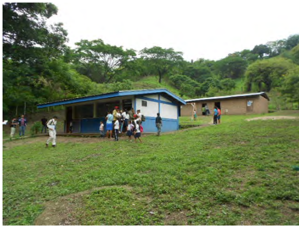
写真-3：傾斜した敷地 斜面を造成して施設を配置している。(ヌエバ・セゴビア県キラリ市サンタ・テレサ, NS-14)
