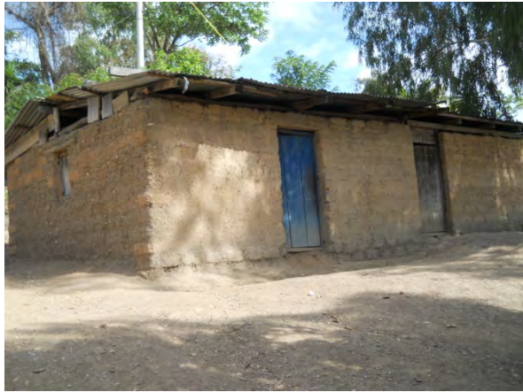
写真-8：土壁校舎 アドベ（日干しレンガ）と呼ばれる土壁の校舎 (マドリス県テルパネカ市サント・ドミンゴ・セクトル・シンコ, M-1)
