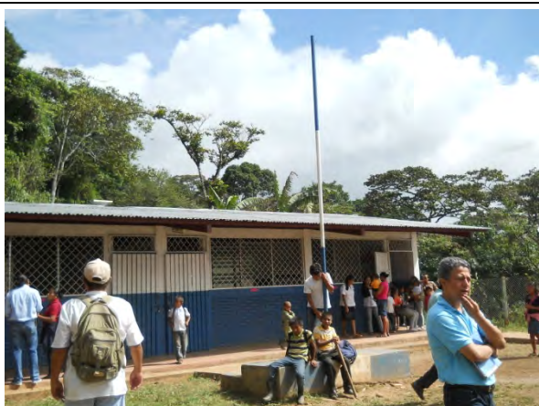
写真-18：他ドナーによる支援（外観） FISE 支援で建設された校舎。（マドリス県テルパネカ市 エル・カルボナル・アリーバ，M-11）
