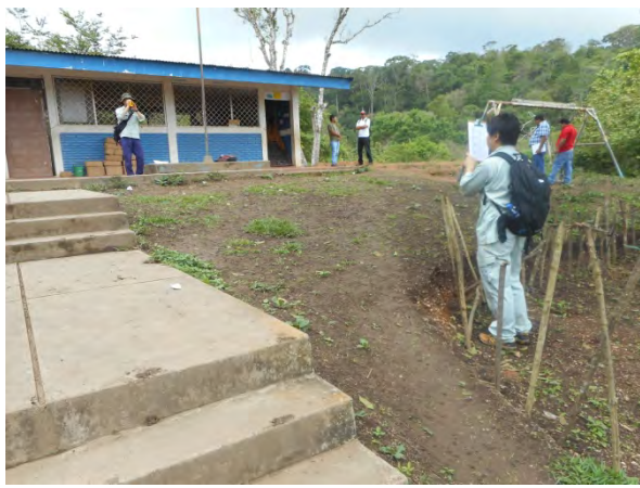
写真-6：傾斜した敷地 敷地の傾斜に対応するため、階段を設けている。(マドリス県サンファンデリオココ市ホセ・マルティ, M-16)
