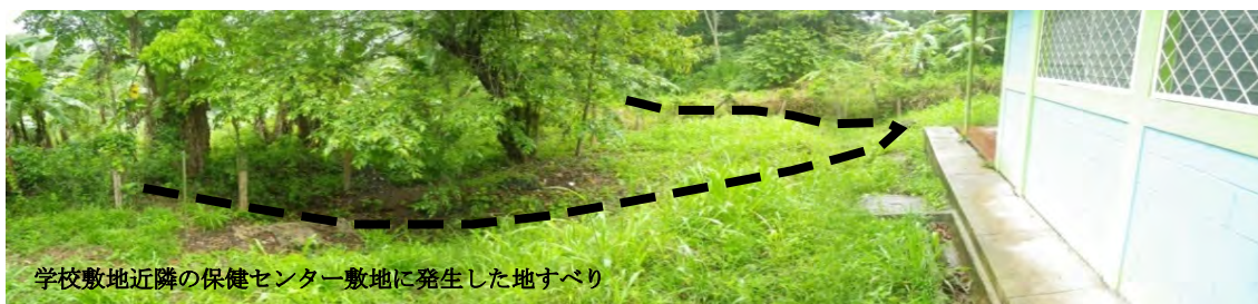
図 3-5 学校敷地近隣の地すべり (保健センター敷地 幅 20m、上下方向の延長は 100m 以上)
