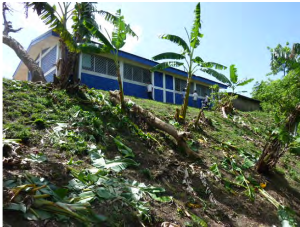
写真-1：狭い敷地 敷地が尾根筋に位置し、かつ狭いため、既存校舎は崖の直ぐ近くに建てられている。(マドリス県サンファンデリオココ市アンドレス・カストロ, M-4)
