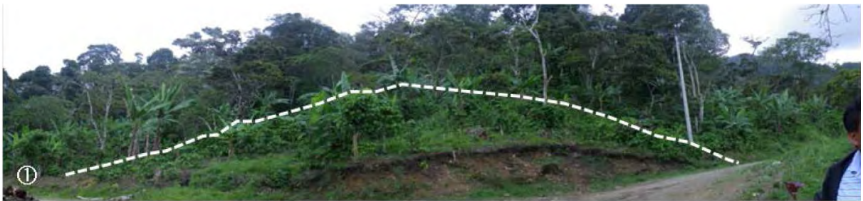
写真 3-1 地すべりブロック頂部に確認できる滑落崖
