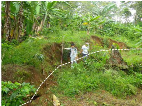
写真 3-2 学校敷地直近の滑落崖
