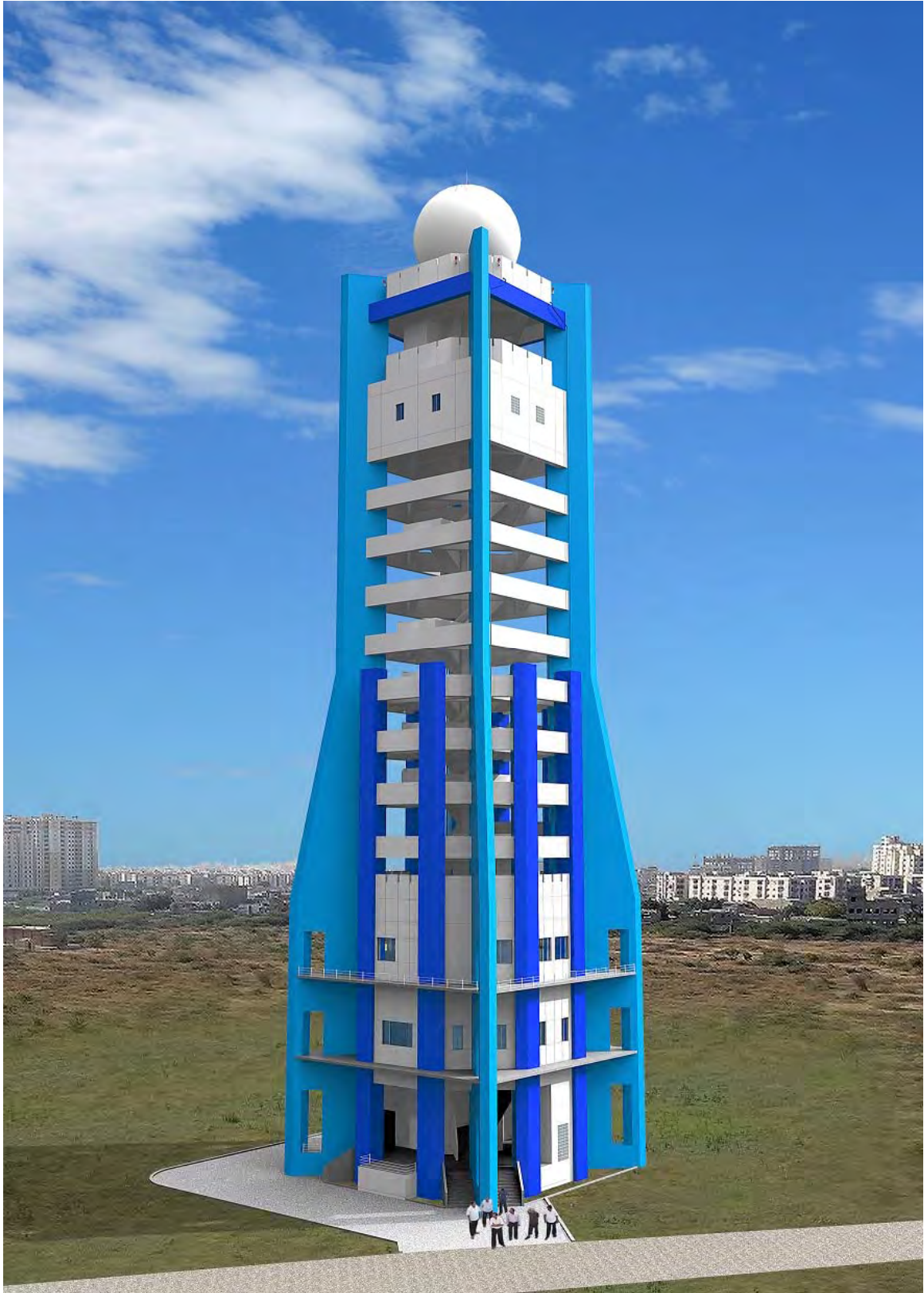
カラチ気象レーダー塔施設
