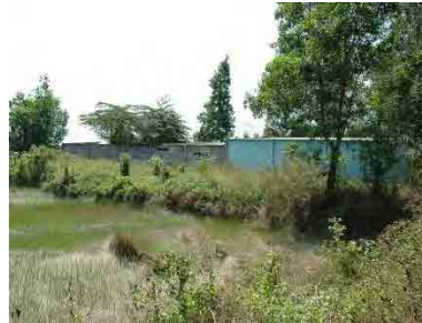
図 16-19 HPC 社員住宅
